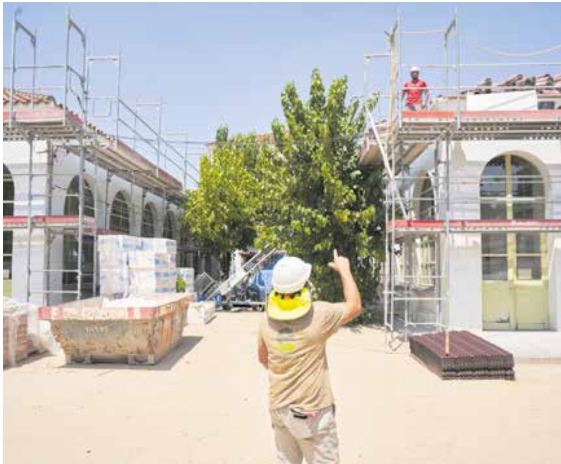
Uns operaris treballant aquest dimarts a l'edifici d'educació infantil de l'escola Emili Carles-Tolrà. || Q. PASCUAL
