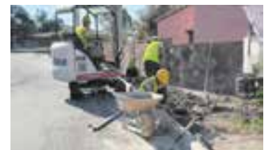
Treballs a les voreres de l'Aire-Sol D.
