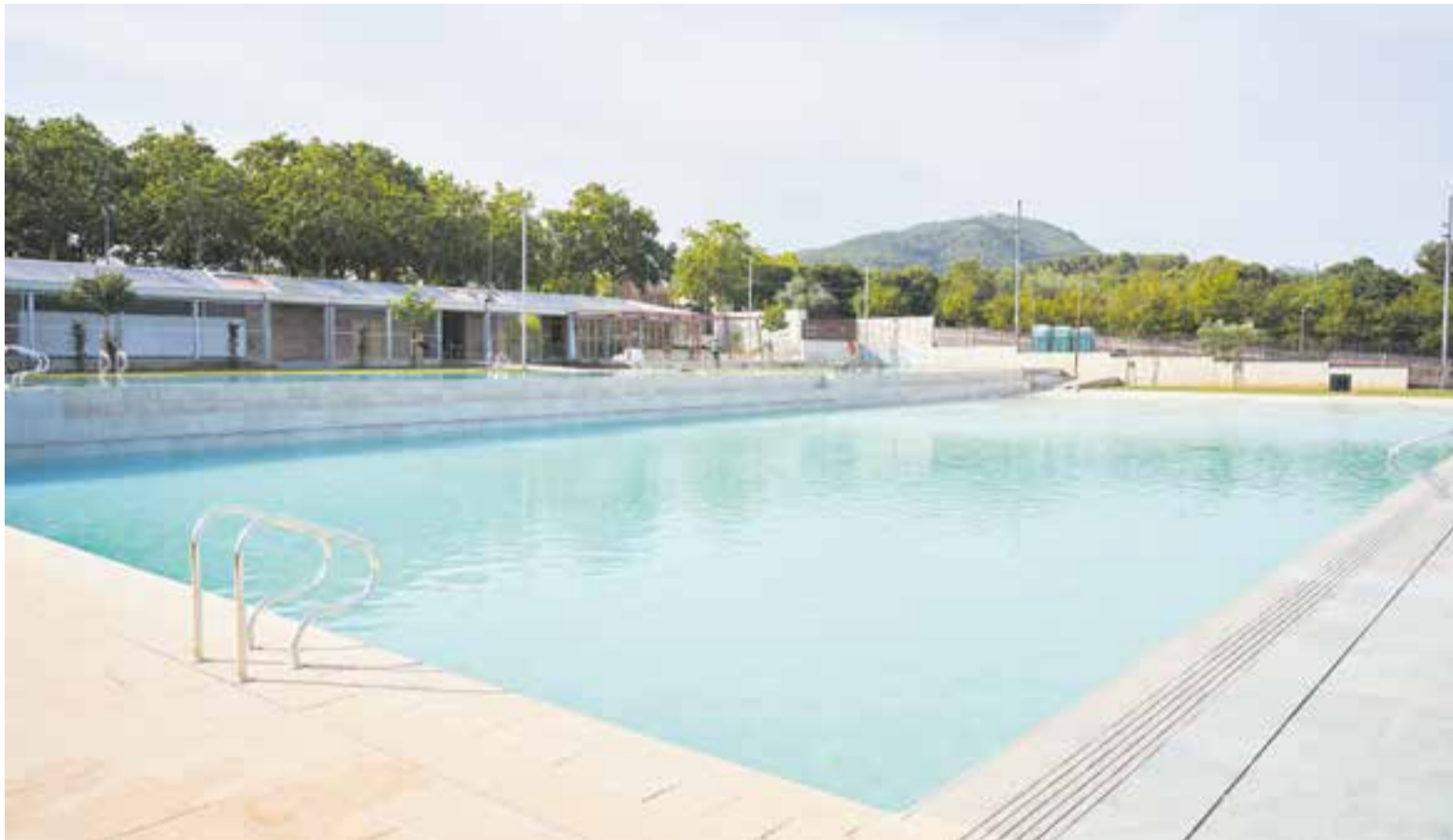
Imatge de la nova Piscina Municipal Colobriers d'aquest dimecres amb el Puig de la Creu de fons, just a tres dies de ser inaugurada. || Q. PASCUAL
