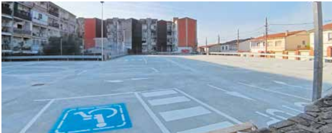
Imatge d'aquesta setmana del nou pàrquing situat al solar de l'antiga fàbrica Pascuet. || M. ANTÚNEZ
