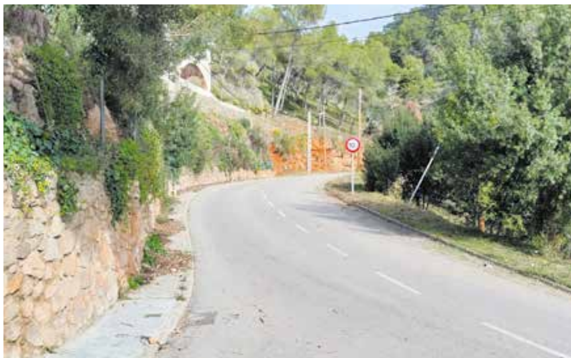
Al Balcó, un dels carrers que s'asfaltaran íntegrament és el carrer del Cim. || AJ. CASTELLAR
