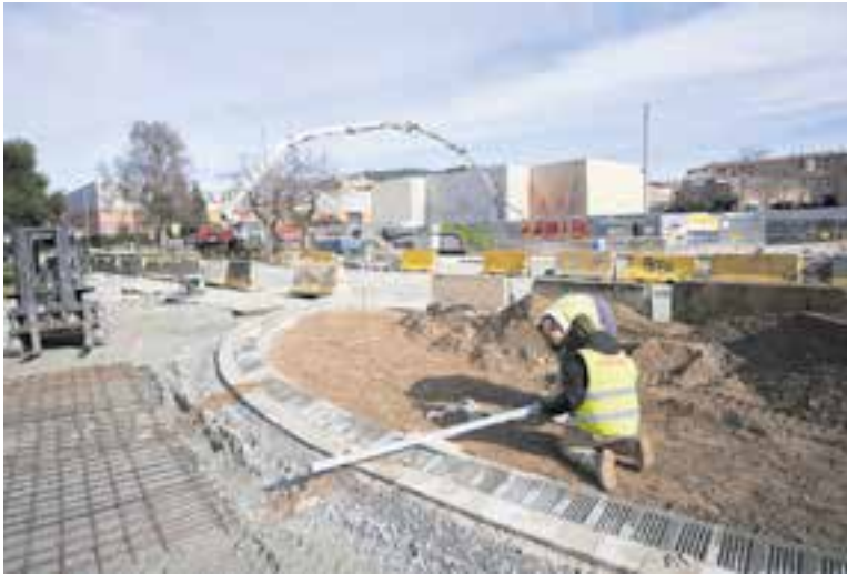
Treballs de construcció de la rotonda davant del Viena, aquesta setmana. || Q. PASCUAL
