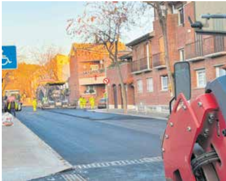
Treballs d'asfaltatge en un tram del carrer Àngel Guimerà || O. F.
