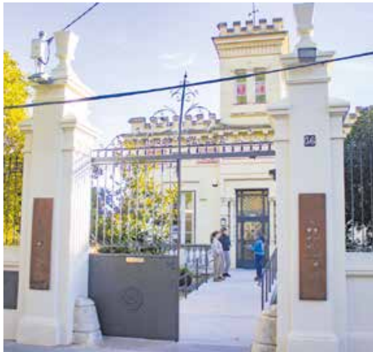
Accés a l'entrada de l'EMM Torre Balada, on s'ha fet una nova rampa d'accés. || A. S. A.
