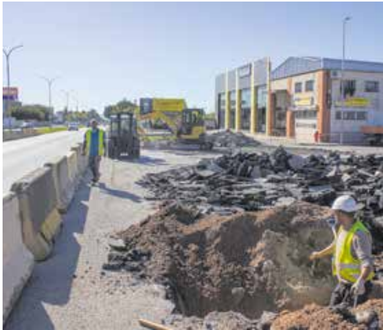
Aspecte de les obres de la rotonda durant aquesta setmana. || A. SAN ANDRÉS
