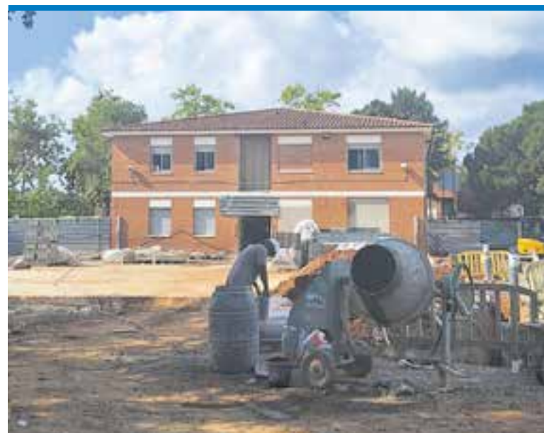
Uns operaris treballant dijous a les obres de l'IE Sant Esteve. || A.J. CASTELLAR
