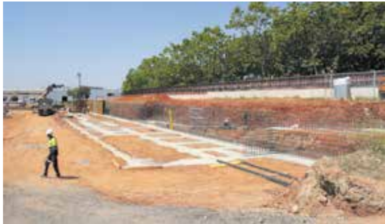
Imatge del juny passat de les obres de la piscina que es vol obrir l'estiu que ve. || A. S. A.
