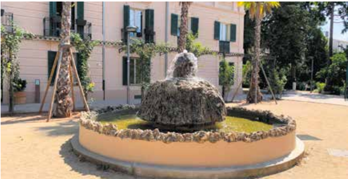
La font ornamental dels Jardins del Palau Tolrà on s'ha renovat l'enllumenat interior del sortidor. || J. RIUS
