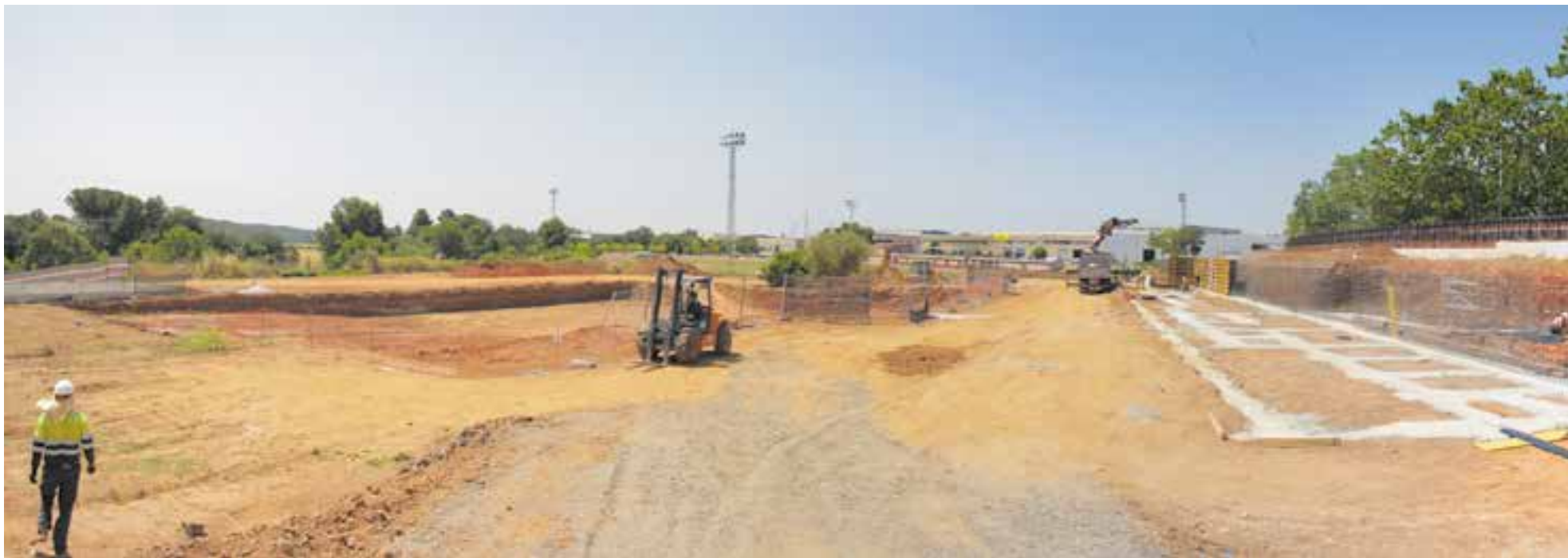
El solar que ocuparan les noves piscines municipals es va transformant en l'aspecte que hauran de tenir a finals de maig del 2026, quan es calcula que s'acabaran les obres. || A. SAN ANDRÉS
