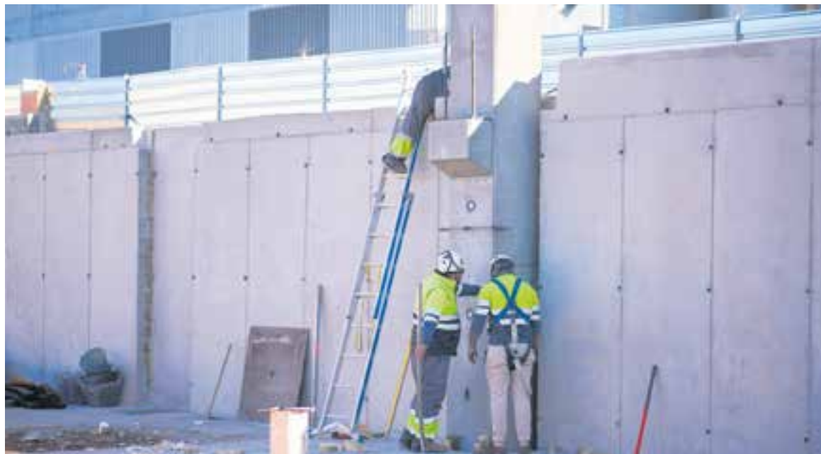
Obra de construcció de la nova nau de La Sirena que s'està aixecant al polígon del Pla de la Bruguera. || Q. PASCUAL
