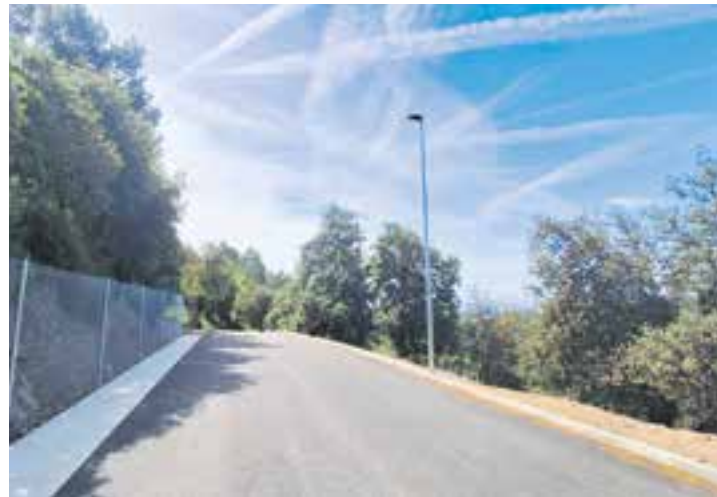
Un dels trams asfaltats al carrer de Can Riera. || AJ. CASTELLAR
