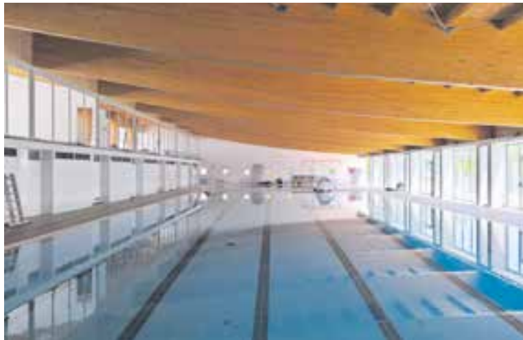
Imatge de la piscina després d'instal·lar-hi la coberta interior. || AJUNTAMENT
