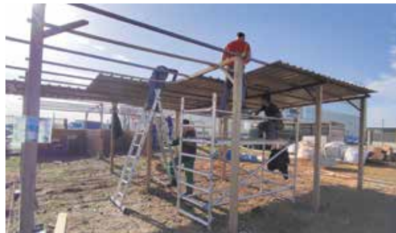
© Reconstrucció de la coberta del compostador.
