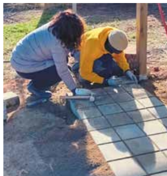
© Instal·lació de llambordes a l'espai de proves de reg.
