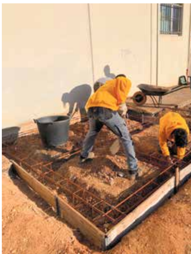
© Preparació de solera de formigó.
