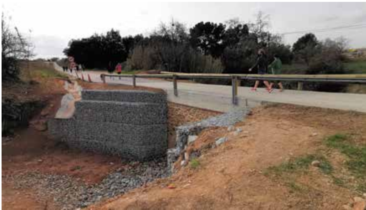
Amb la rehabilitació, s'ha assegurat l'estabilitat dels talussos amb murs d'escullera i de gabions. || AJUNTAMENT
