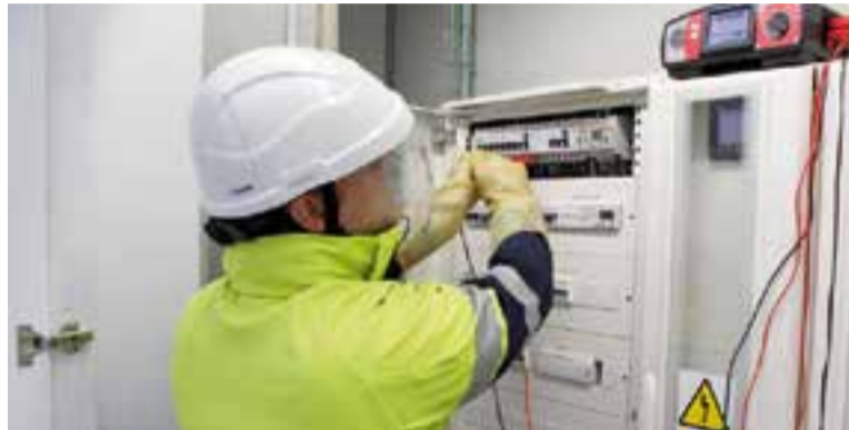
Proves en un panell elèctric. || CEDIDA
